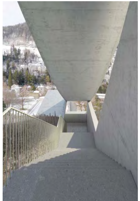
BLICK RICHTUNG SAND
