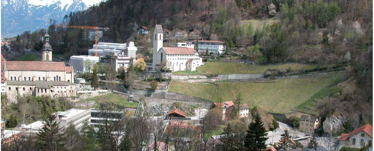
Chur: Kantonsschule Plessur - Halde Übersicht
