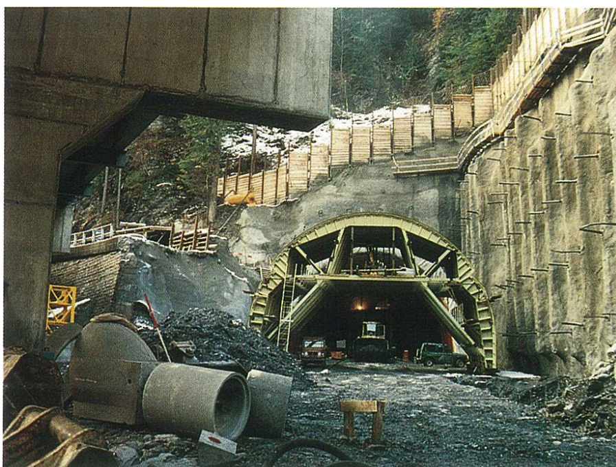
Der Voreinschnitt für das Nordportal mit der fertig montierten Gewölbeschalung.
