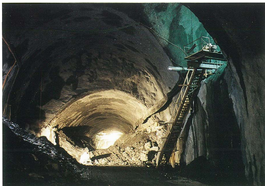
Die Tunnelröhre im Bereich der Zentrale Thusis mit Ausstellbucht.
