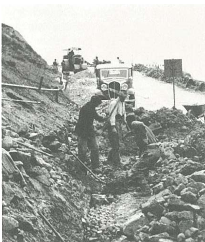
Ausbau der Julierstrasse, 1935
