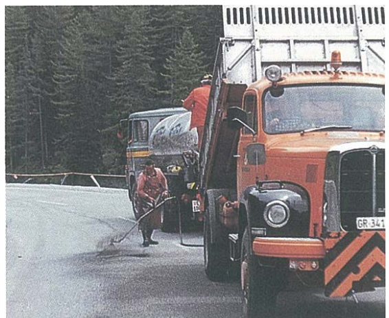
Die Sanierungen von Belagsrissen am Flüela
