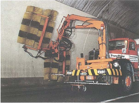
Reinigung der Tunnelwände
