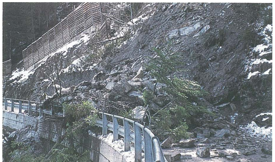
Felsrutsch auf der Verbindungsstrasse Chur - Tschierschen
