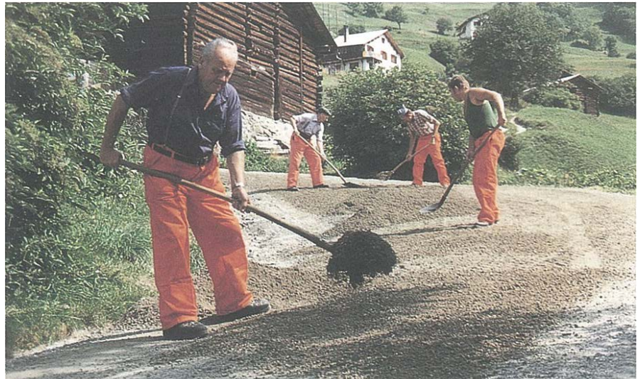
Unterhaltsarbeiten an der Verbindungsstrasse Paspels-Trans.
