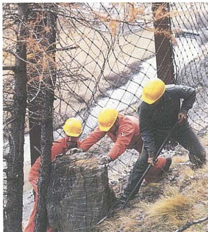
Strassenwarte beim Räumen eines Steinschlagnetzes
