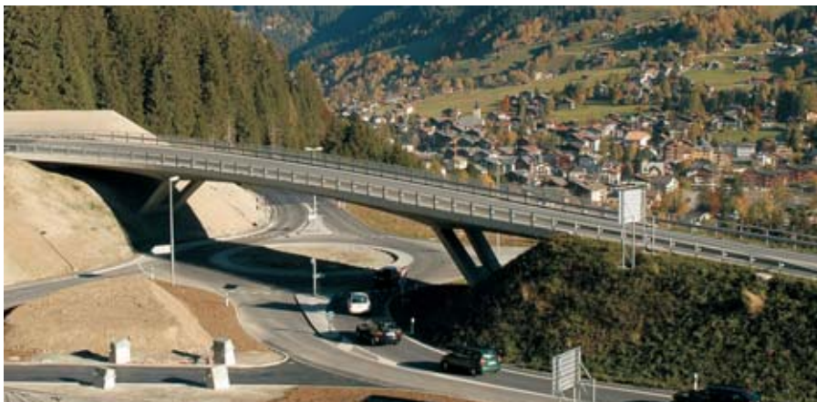
Hoch über Klosters wird der Durchgangsverkehr nach der Fahrt durch den Gotschnatunnel nach Davos geleitet.
