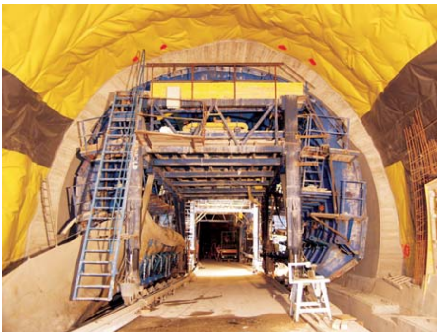
Betonieren des Innenrings des 4207 Meter langen Gotschnatunnels
