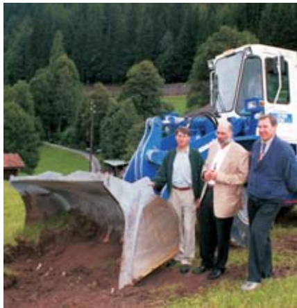
Am 24. August 1995 erfolgte der erlösende Spatenstich mit dem Pneulader
