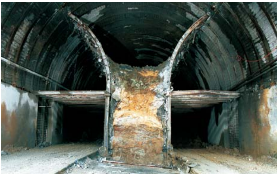
Deutsche Kernbauweise im fallenden Vortrieb von Selfranga. Der weitgehend kakiritisierte Fels im Kern wird wie ein Lockergestein mit dem Abbauhämmer gelöst
