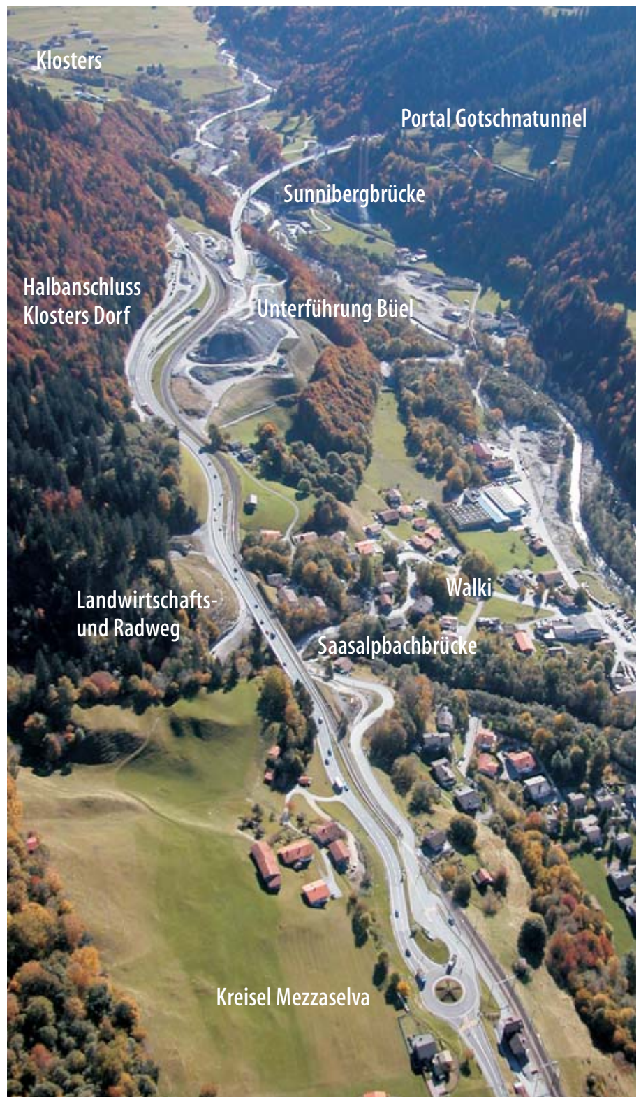
Die ab dem Kreisel Mezzaselva neu gebaute Prättgauerstrasse führt in einem eleganten Bogen über die Sunnibergbrücke in den Gotschnatunnel.
