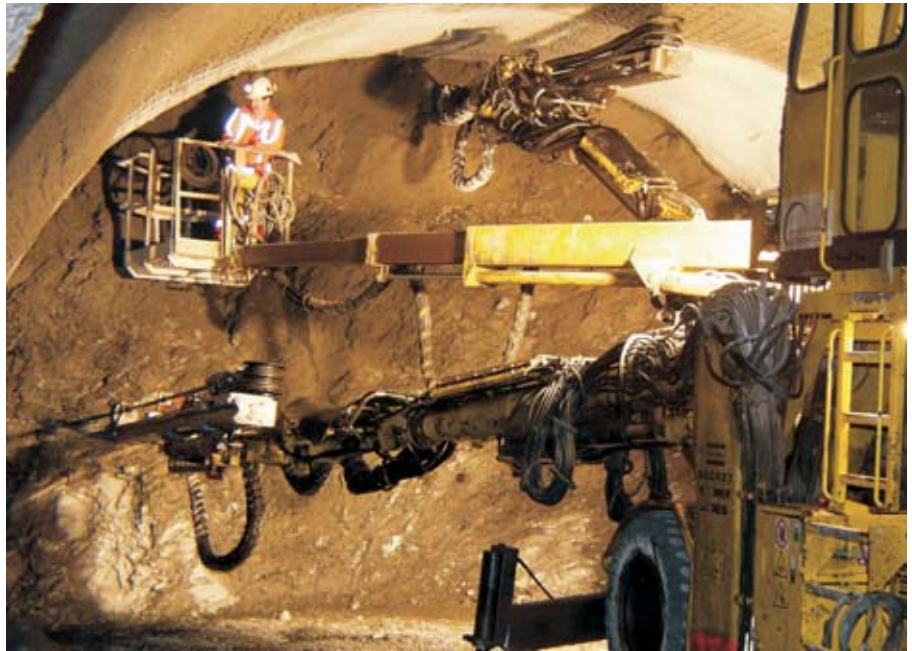
An der Tunnelbrust des Sprengvortriebs
