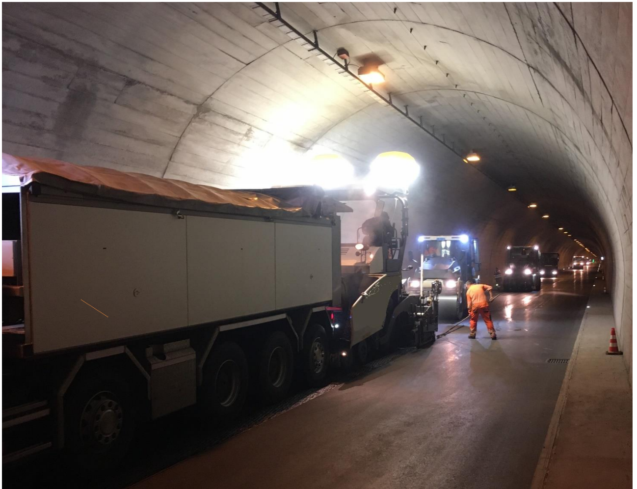
H417b Landwasserstrasse, Landwassertunnel, km 16.90 – 19.80
