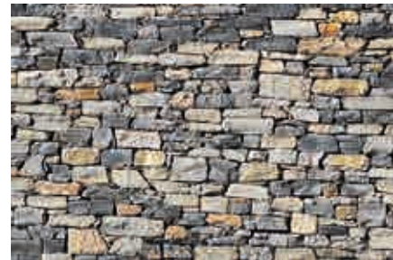
Abb.3: Lagerhaftes Trockenmauerwerk in Pierre calcaire de St-Léonard
