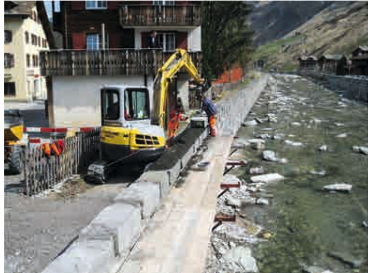
Abb.3: Mauern Hochwasserschutz Vals
