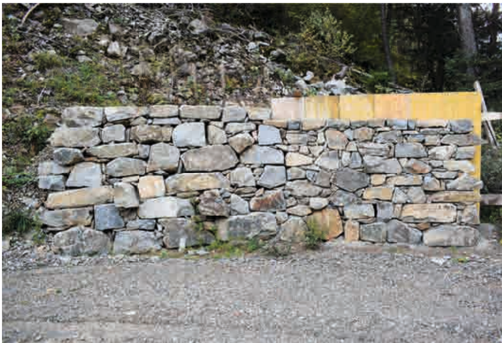
Abb.4: Beispiel Trockenmauerwerk
