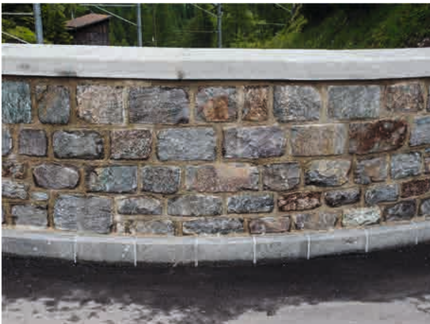
Abb.5,6: Überführung Naz, Mauerwerk in Farriola Quarzporphyr, Eck- und Kranzsteine Bogen, Randsteine und Abdeckplatten in San Bernardino Silber, siehe 2.3
