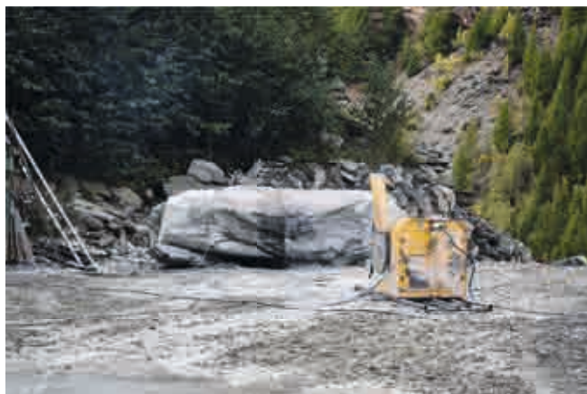
Abb.4: Zerkleinern eines Grossblocks mittels Seilsäge
