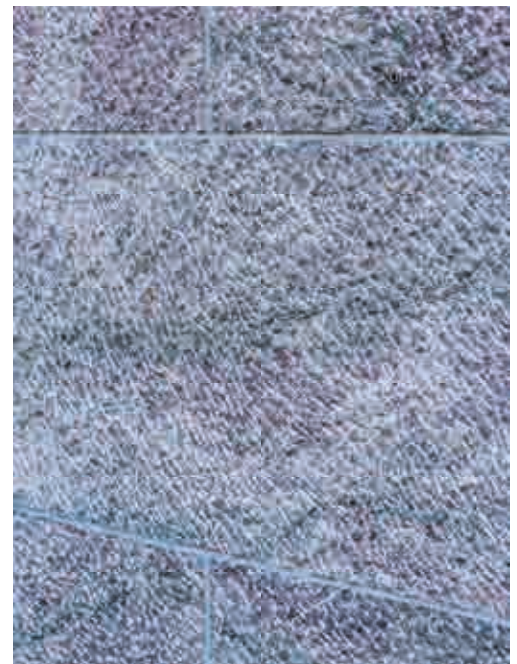
Abb.6: Fassadenplatten mit punktgespitzter Ansichtsfläche
