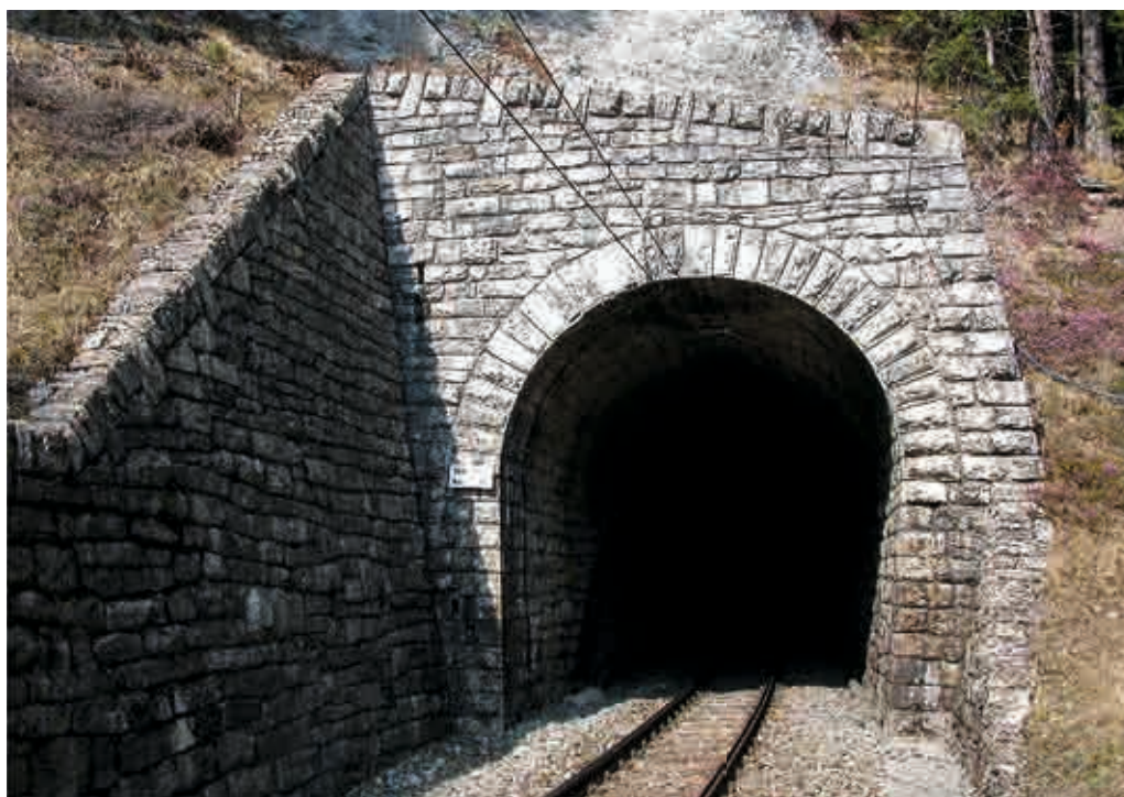
Abb.11: Portal Chrummwag-Tunnel vor Versam. Heller Kalkstein von Tamins. Charakteristisch die Verzahnung der Mauerkrone mit dem darunter liegenden Mauerwerk [Hauptinspektion Rhätische Bahn]
