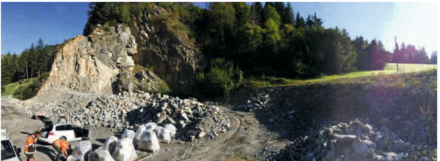
Abb.4: Panoramabild, links der aktuelle, rechts der projektierte Abbauperimeter
