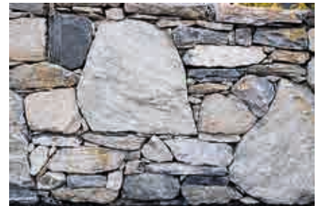
Abb.10: Formwildes Mauerwerk in Pierre calcaire de St-Léonard
