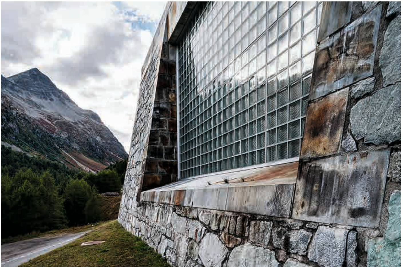
Abb.4: Unterwerk Albanatscha, Silvaplana, Arch. H.-J. Ruch. Steine aus dem Aushub, Stürze in vorgespanntem Campascio-Granit, Foto Christian Helmle
