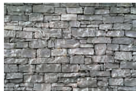
Abb.5: Trockenmauerwerk in Calanca Gneis
