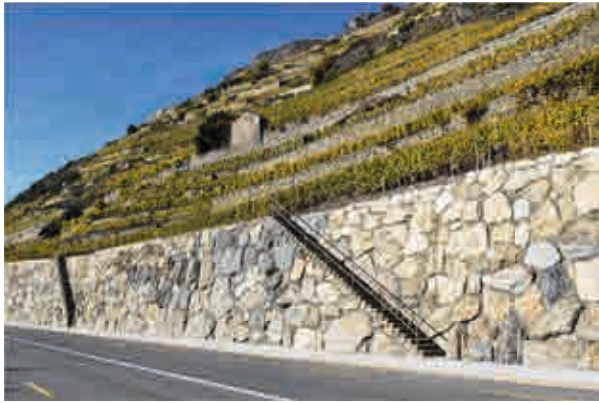
Abb.2: Trockenmauern in den Rebbergen zwischen Sion und St-Léonard
