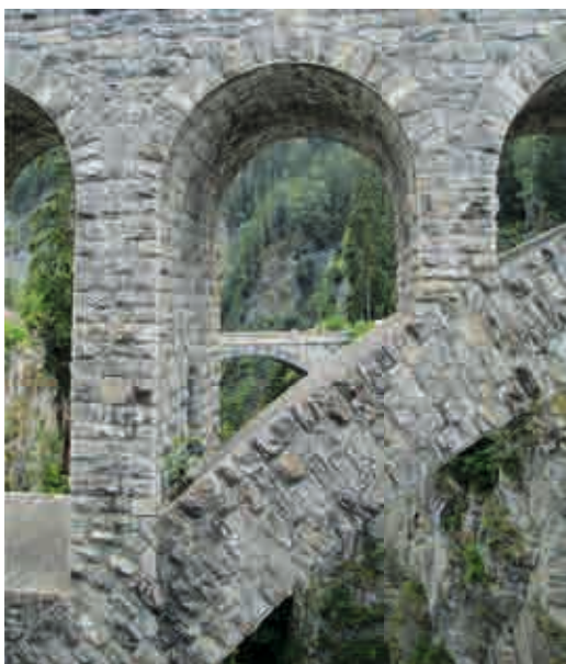
Abb.8: Solis Viadukt, Nahaufnahme
