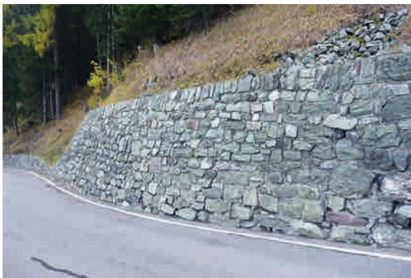
Abb.2: Julierstrasse, typisches formwildes Mauerwerk aus grünem Metabasalt
