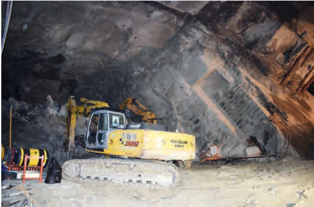
Abb.2: «Schuttern» nach einer Sprengung
