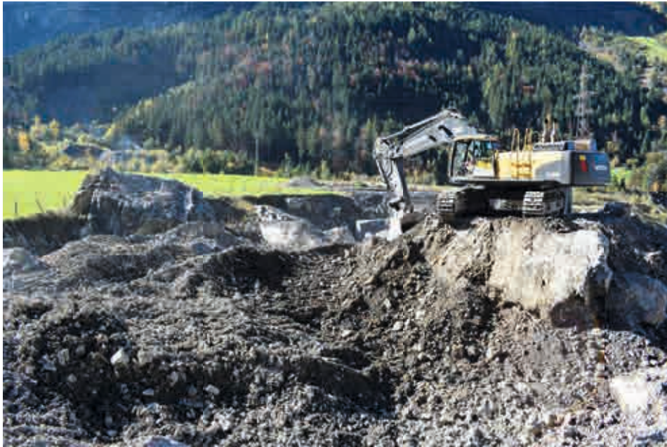
Abb.2: Abbau mit dem Bagger in offener Grube
