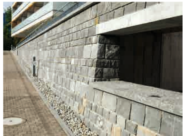
Abb.5: Natursteinmauerwerk in Sachseln
