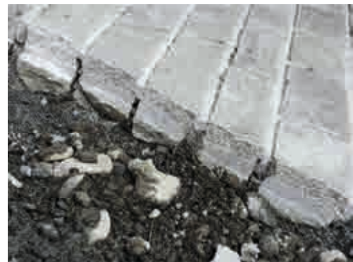
Abb.3: Steine mit gestockter Ansichtsfläche
