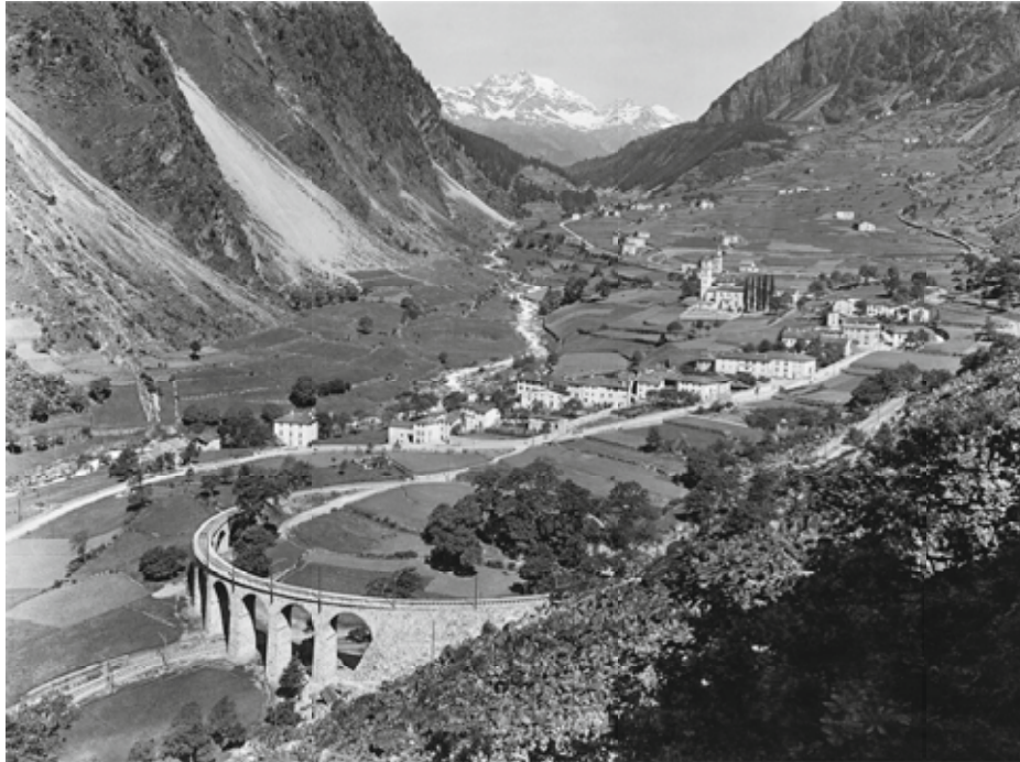
Abb.3,4,5: Historische Bilder des Kreisviadukts von Brusio
