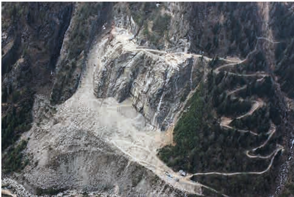
Abb.1: Steinbruch Motto dei Rämpan
