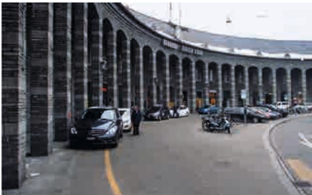
Abb.3: Mauerwerk aus Maggia Gneis mit gespaltenen kleinen Mauersteinen und bearbeiteten, hier gestockten, Ecksteinen
