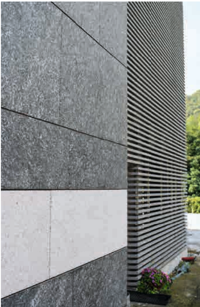
Abb.4: Helle Wandfliesen in Granito San Fedelino am Sitz der Succetti Luciano srl in Chiavenna (dunkle Fliesen in Serizzo Dubino, siehe S. 198)
