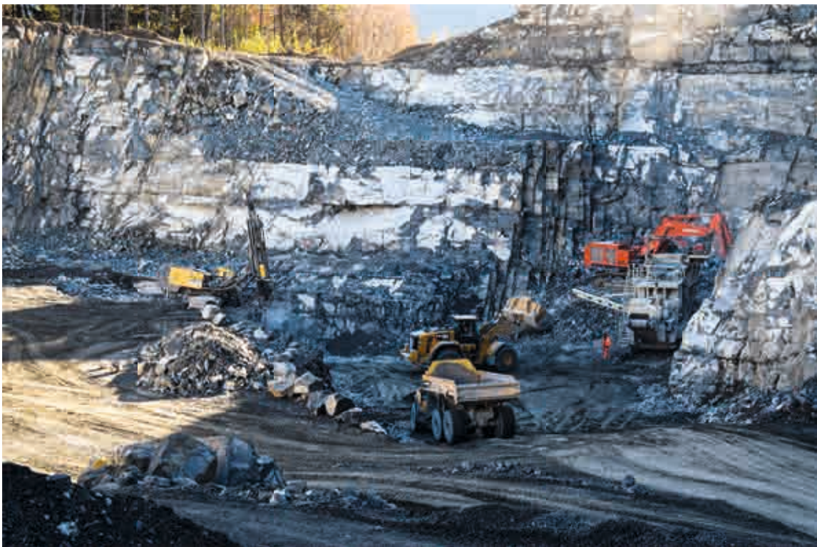
Abb.1: Abbau des Grès des Carrières
