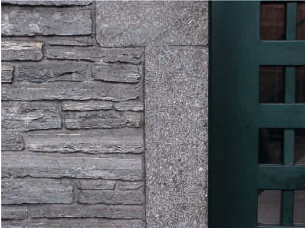
Abb.1: Türleibung mit gestockter Oberfläche
