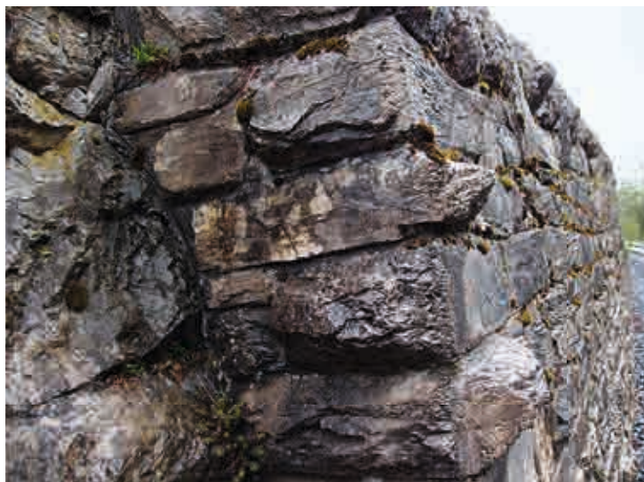
Abb.10: Reizvolles Spiel mit glatten und bossierten Flächen. Stützmauer aus dem gleichen Material wie unten. Farsch, oberhalb der Vorderrheinbrücke der Bahnlinie Reichenau-Tamins
