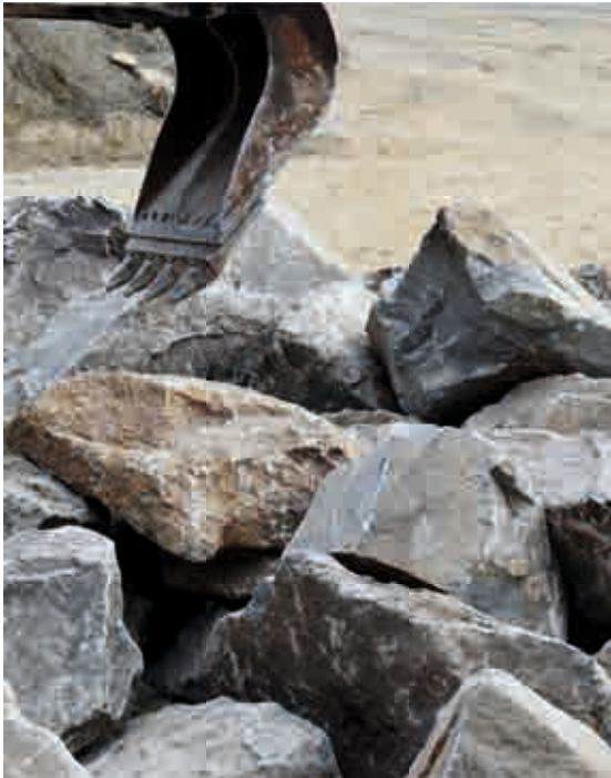
Abb.2: Aussortieren der Mauersteine
