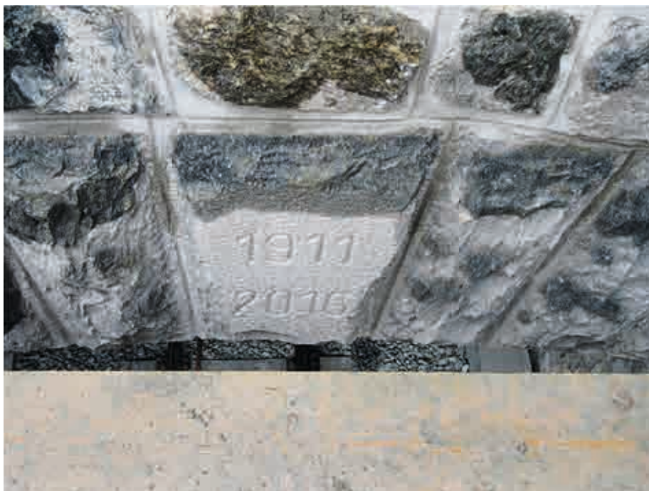
Abb.4: Detail Schlussstein, Sasslatsch-Tunnel
