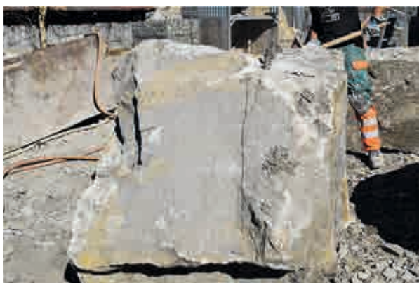
Abb.6: Blöcke werden händisch gespalten
