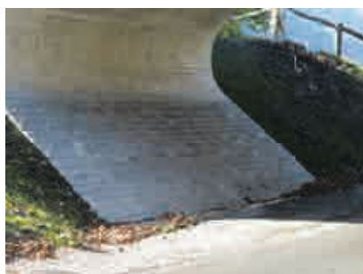
Abb.7: Böschungsbefestigung RhB-Überführung Neugut
