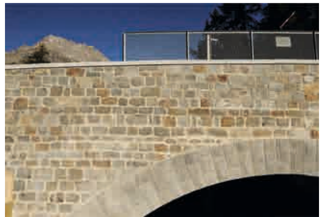
Abb.2: Kranzsteine in San Bernardino Silber, Mauerwerk in aufwändig gerichtetem Farrisola Quarzporphyr
