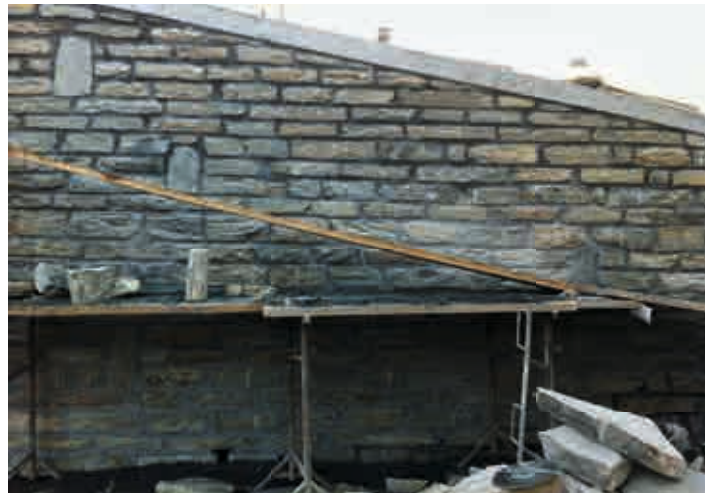
Abb.1: Lagerhaftes Mauerwerk in Luserna Gneis
