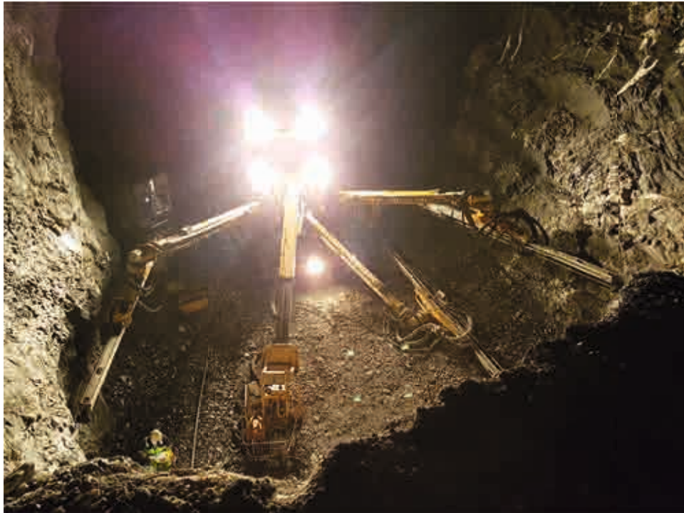
Abb.1: Bohren der Sprenglöcher mit dem Bohrjumbo
