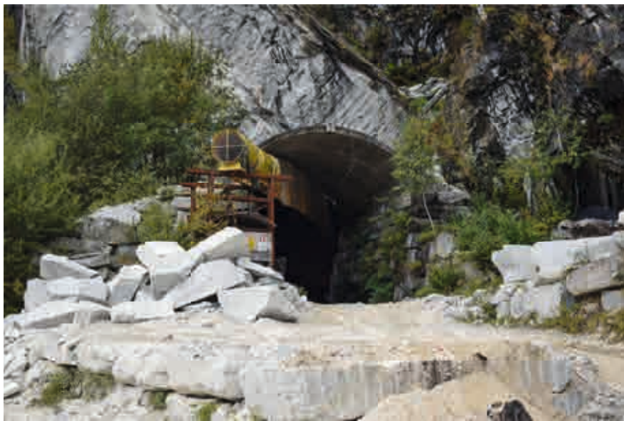
Abb.3: Plattige Blöcke vor den Stollenportal
