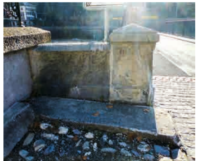
Abb.7: Widerlagerbekrönung bei der Rheinbrücke Reichenau in Sandstein (1881)
