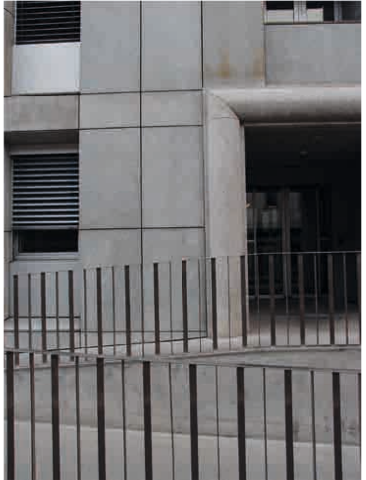
Abb.6: Wandfliesen aussen, 3 cm stark, geschliffen
