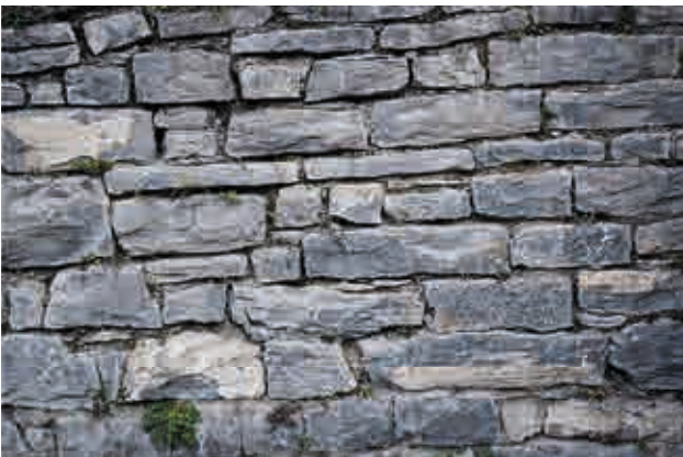
Abb.1: Mauerwerk aus Ringgenberger Kalkstein mit durchziehenden Lagerfugen
