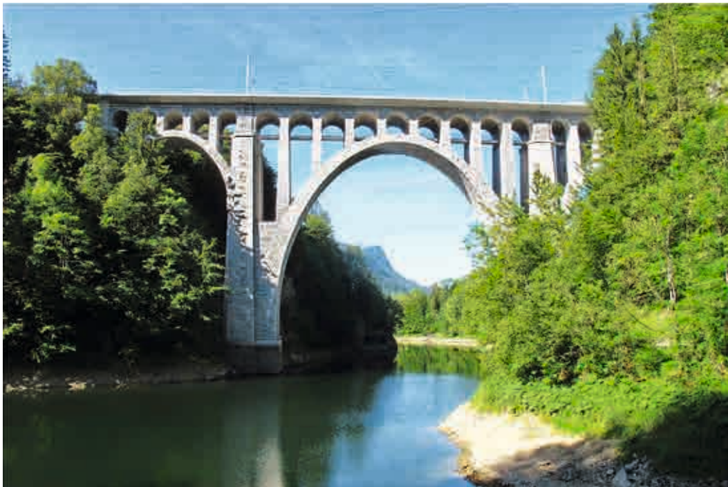
Abb.5: Viaduc du Day, erbaut 1923-1924, Mauerwerk aus Calcaire d'Arvel und Saint-Triphon
