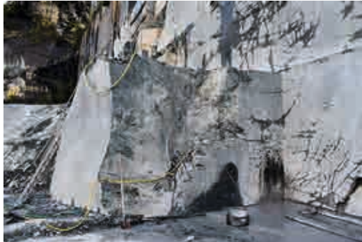
Abb.2: Abbau mit Seilsägen
