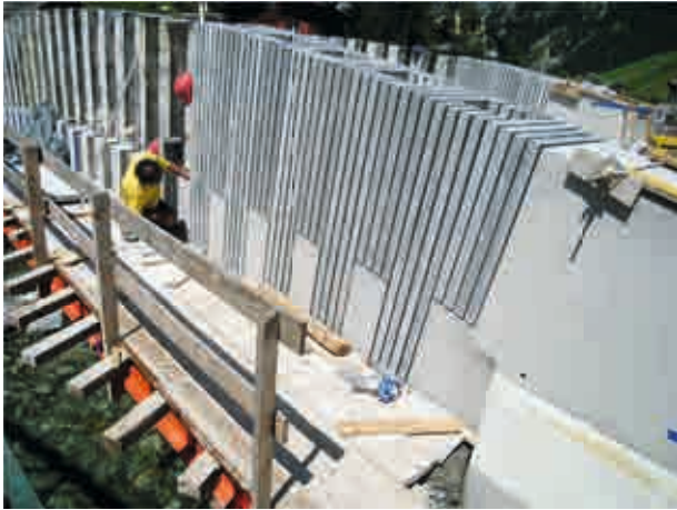
Abb.2: Versetzen der Platten für die tragenden Wände
