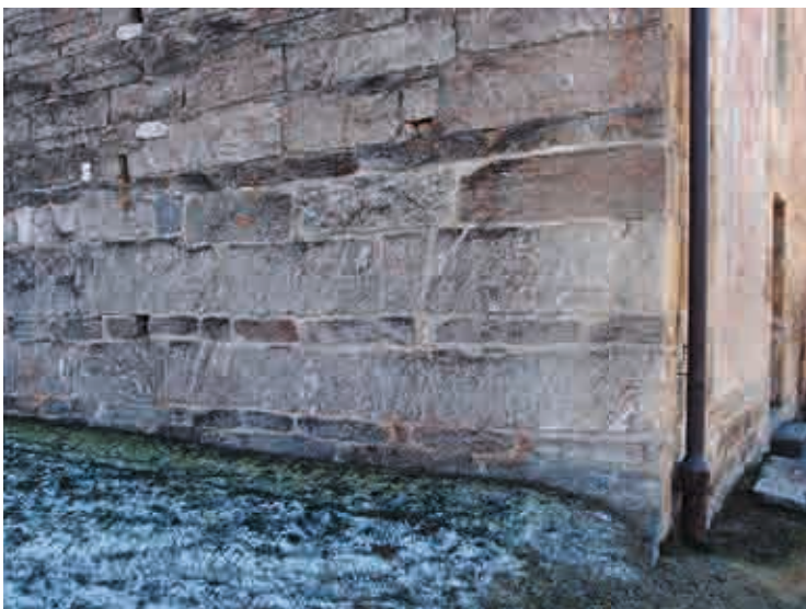
Abb.6: Kirche St. Martin in Zillis, Nordostecke: Cipollin-Marmor mit brauner Patina, abwechselnd liegend und «auf dem Spalt» (hochkant) vermauert. Blöcke bis zu 373 cm Länge
