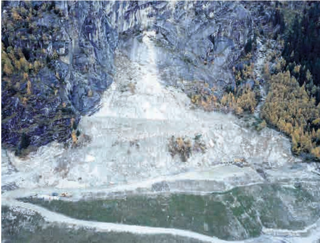
Abb.1: Steinbruch Gütli Gurtnellen, Abbau von Blöcken mit dem Bagger
