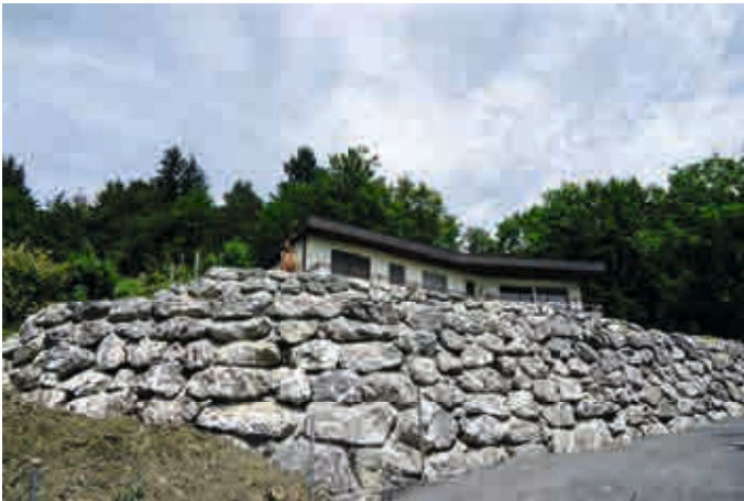
Abb.5: Blockmauer bei privatem EFH in Malans
