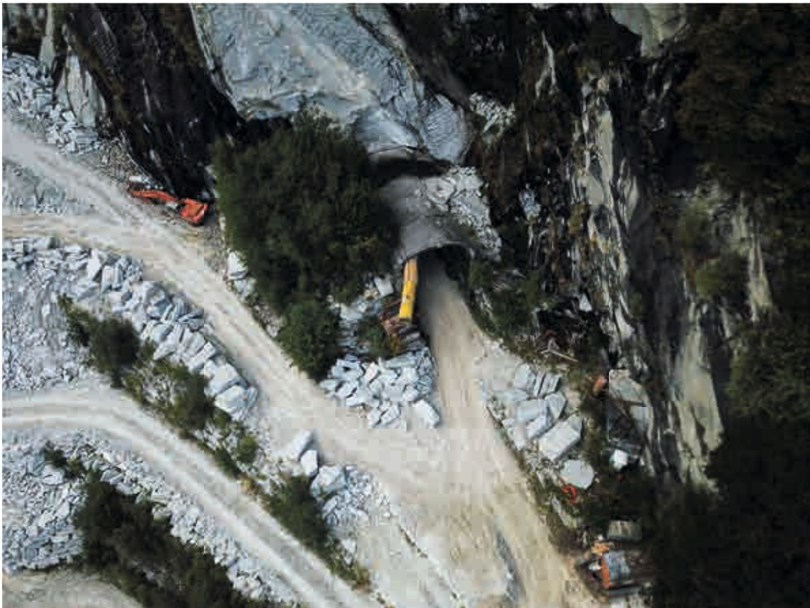
Abb.1: Stollenportal im ehemaligen Hangbruch Cäva Böcc in Promontogno
