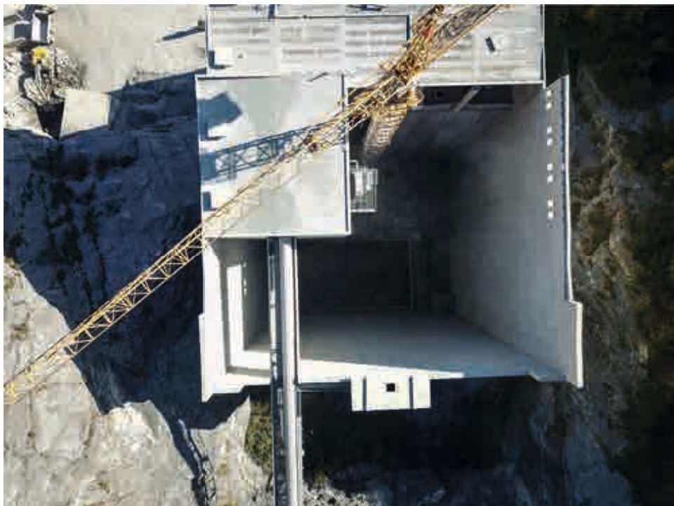
Abb.2: Aufbereitungsanlage mit Förderband von oben
