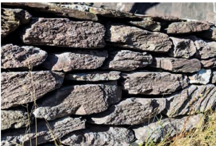
Abb.5: Trockenes Mauerwerk
