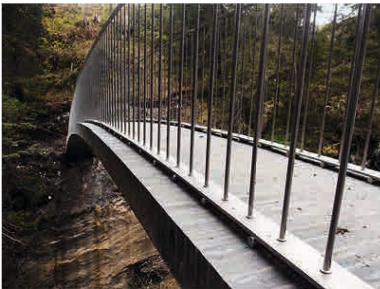
Abb.4: Trutg dil Flem, Wasserfallbrücke; Bogen aus Valser Gneis mit oben liegenden Spannbändern
