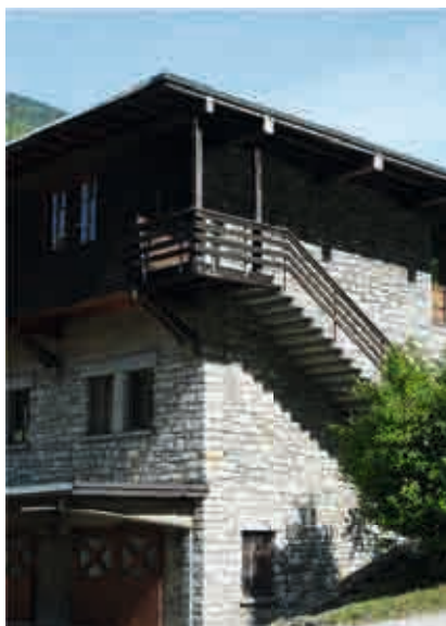
Abb.5: Mauerwerk und Trittplatten aus Gneis, Biasca, Arsenale Militare, Arch. Augusto Jäggli mit Carlo und Rino Tami, 1942 (SZ)
