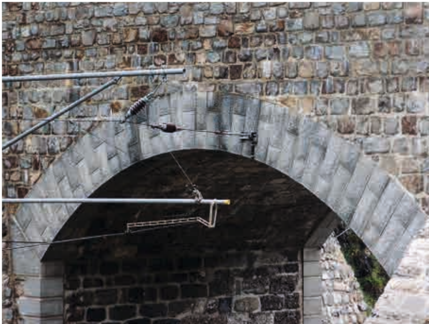
Abb.5,6: Überführung Naz, Mauerwerk in Farriola Quarzporphyr, Eck- und Kranzsteine Bogen, Randsteine und Abdeckplatten in San Bernardino Silber, siehe 2.3
