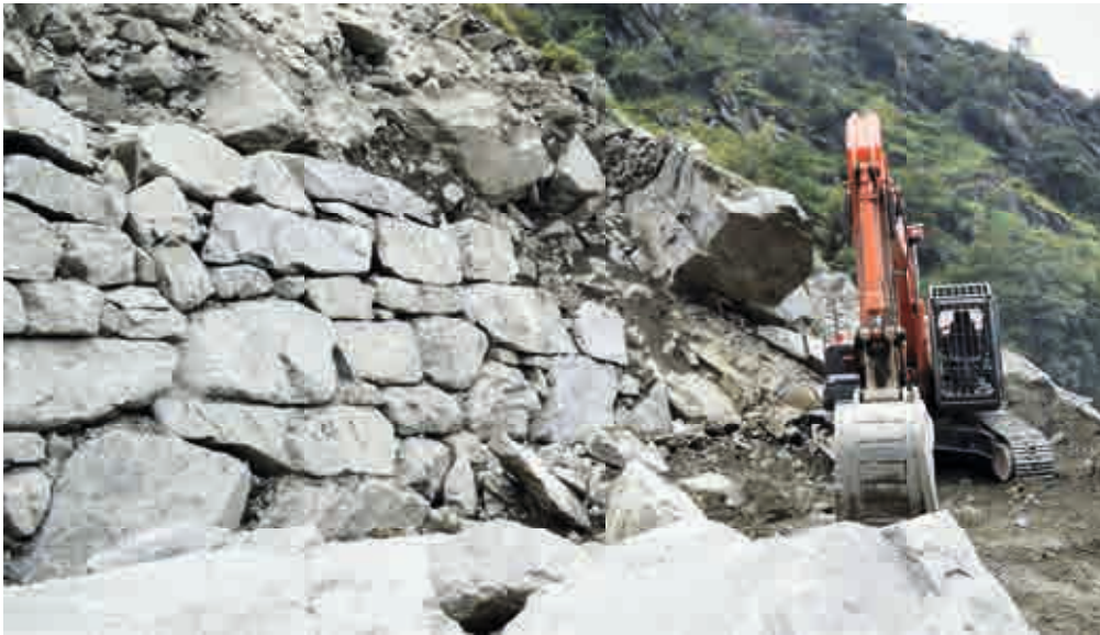
Abb.2: Abbau von Grossblöcken mit dem Bagger
