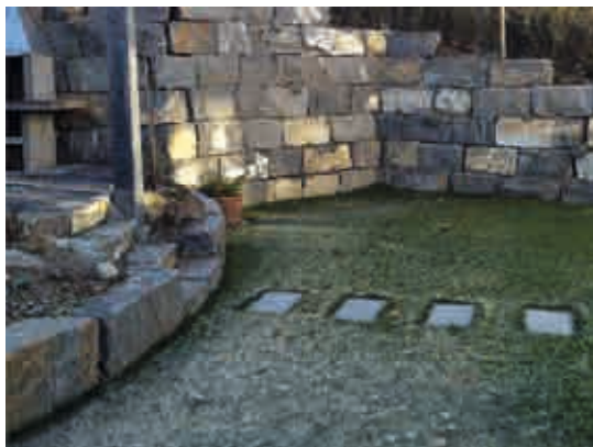
Abb.4: Unvermörtelte Blockmauer in Dänikon
