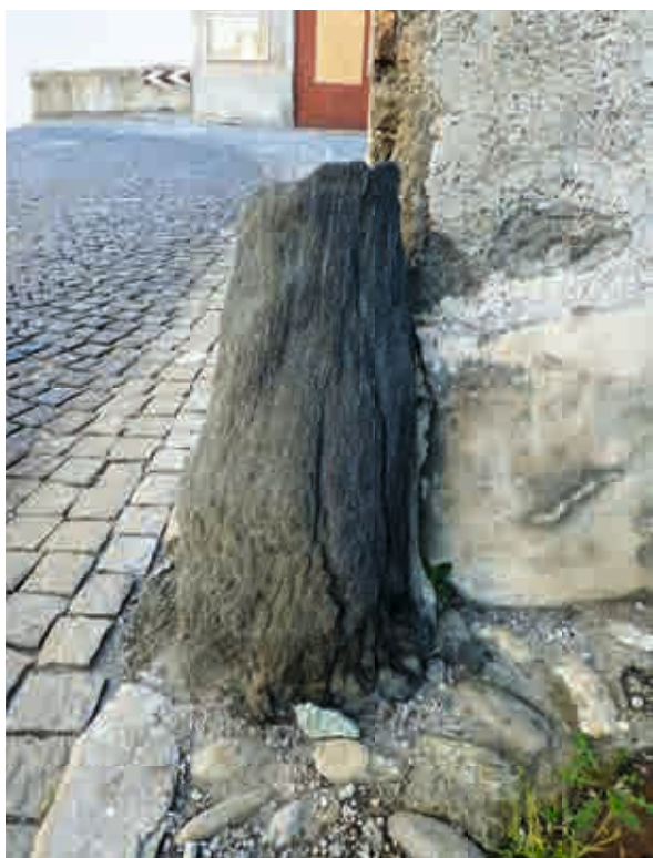
Abb.9: Stark verwitterter Paracarro aus dunklem Kalkschiefer beim Schloss Reichenau
