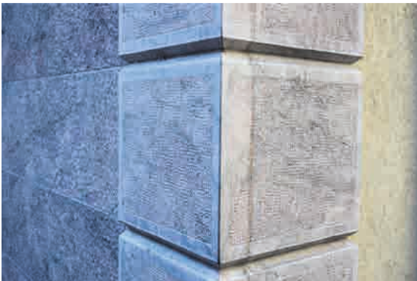
Abb.5: Ecksteine mit gestockter Oberfläche und Randschlag, Kanten oben und unten gefast
