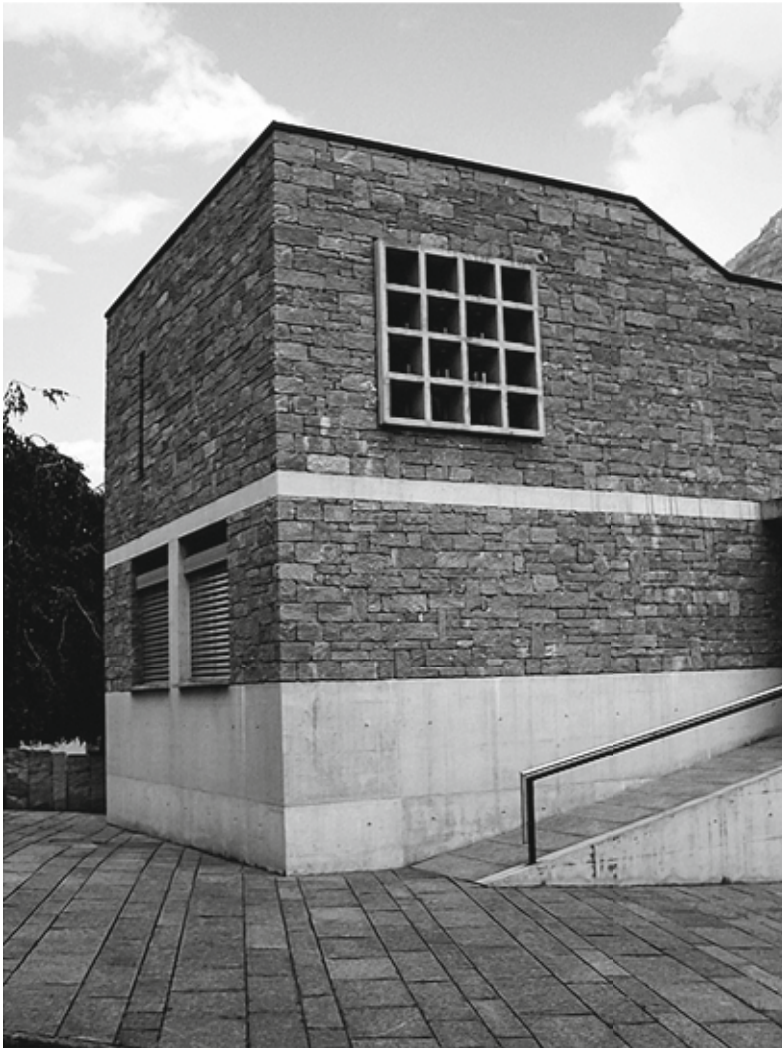
Abb.4: Mauerwerk der Fassade des Gemeindehauses von Iragna
