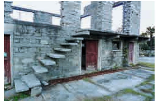
Abb.2: Mauerwerk, Trittplatten, Konsolsteine und Balkonplatte aus Gneis im Dorf Iragna
