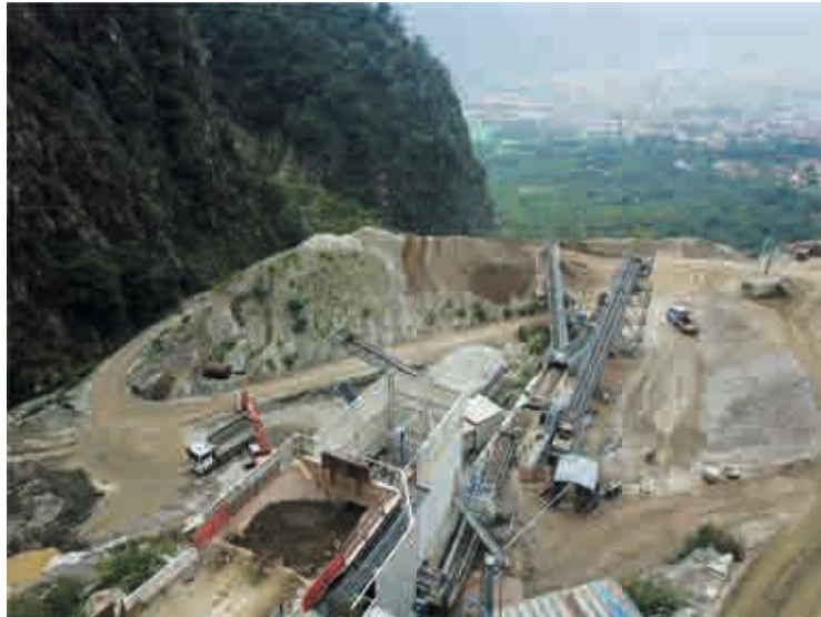
Abb.2: Aufbereitungsanlage im Steinbruch
