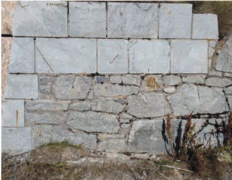
Abb.4: Unten Beispiel von formwildem Mauerwerk mit unbearbeiteten Steinen, oben Beispiel mit gesägten Steinen
