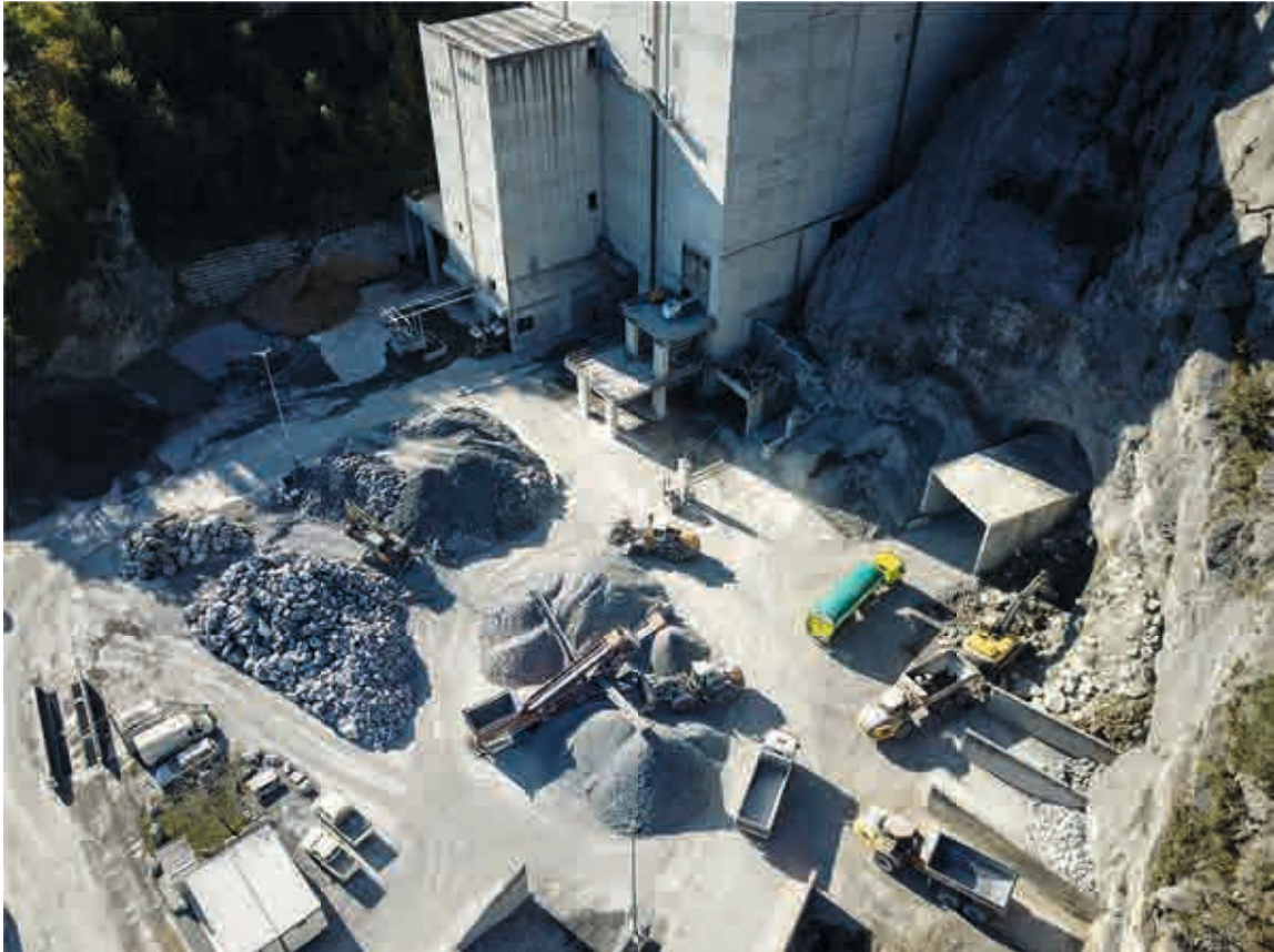
Abb.3: Vorplatz Steinbruch Schollberg mit Stollenportal und Aufbereitungsanlage
