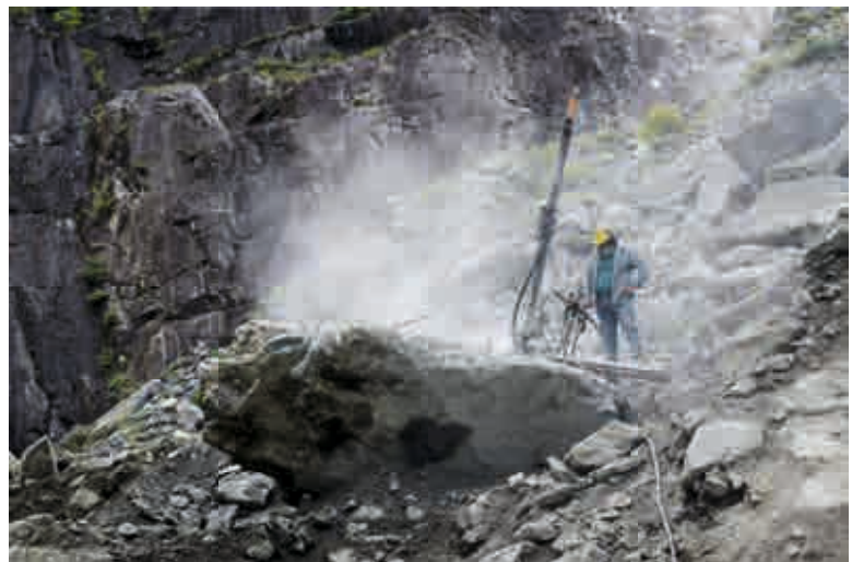
Abb.3: Bohren der Sprenglöcher in Grossblock
