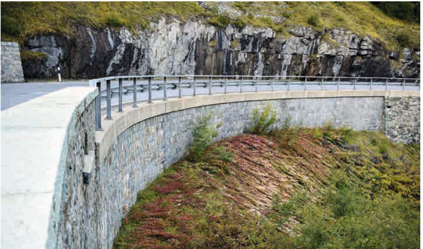
Abb.5: Beispiel einer Stützmauer in Juliergranit, nahe Sur
