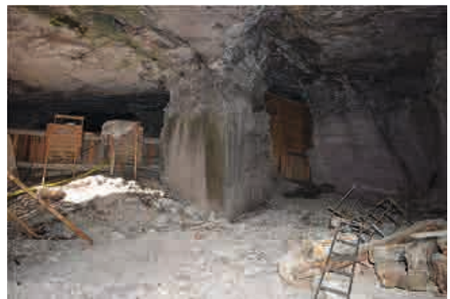
Abb.3: Abbau unter Tage
