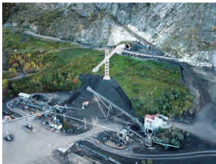
Abb.2: Portal Abwurfstollen mit anschliessender Förderanlage
