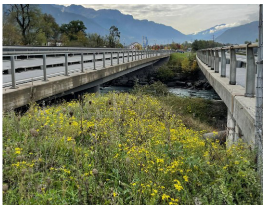
Abbildung 14: Abschnitte zwischen Kantons- und Nationalstrassen inkl. Fließgewässer dicht bewachsen mit Schmalblättrigem Greiskraut. (Foto: Gregeco GmbH, 2022)
