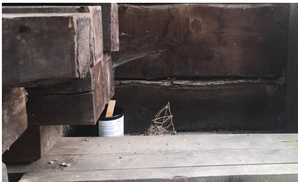
Figura 5: Posizionamento di una trappola sotto alcune travi. (Foto: Dario Somaini, 2019)
